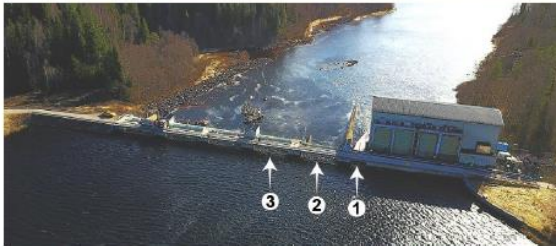
Figur 5. Skymnäs kraftstation och dam från uppströmssidan (överst) och nedströmssidan (nederst). Prioriteringsordning för spill i utskov anges med siffra för respektive utskov.
